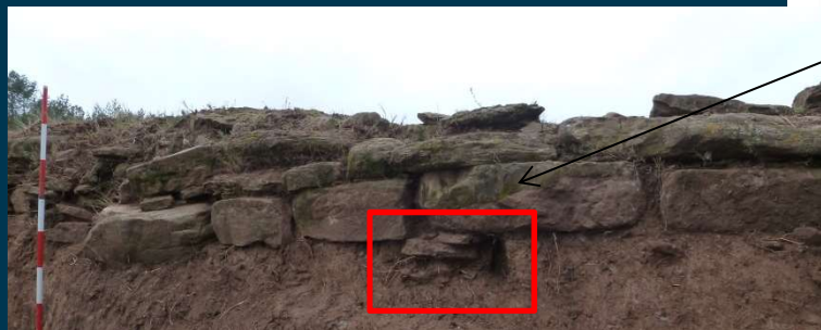
Mur fase II
